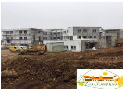
Projet de l'EHPAD de Brest en pleine réalisation ; ouverture prévue : mai 2017.
